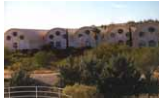
[그림 68] Energy Center 전경
