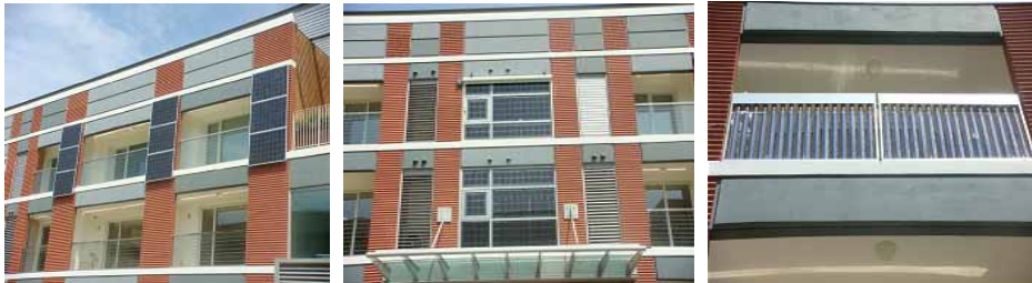
[그림 107] 태양광 시스템 및 태양열 집열판
