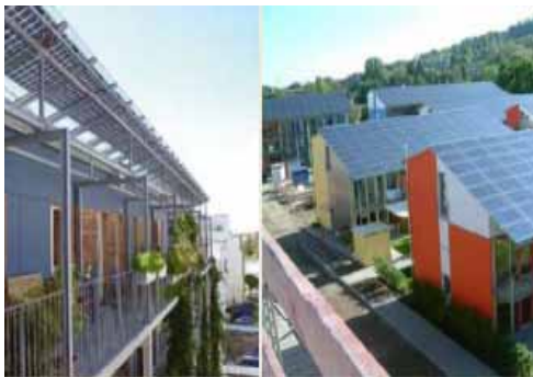
[그림 39] 건물지붕에 설치된 태양전지판
