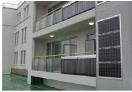
[그림 119] 진공관식 태양열 집열기(BIPV)
