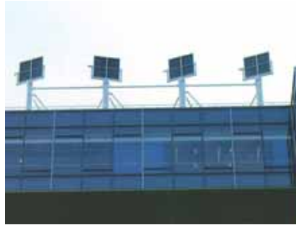
[그림 53] Heliostats의 자연채광
