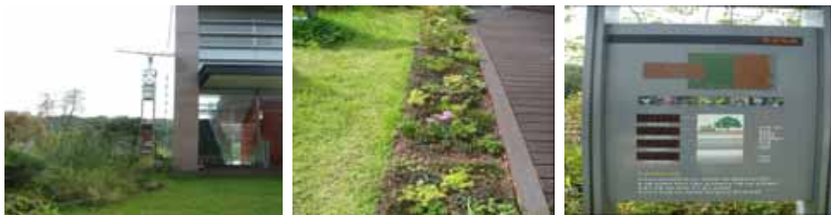
[그림 108] 옥상녹화와 옥상녹화에 의한 옥상부의 온도변화 감지기
