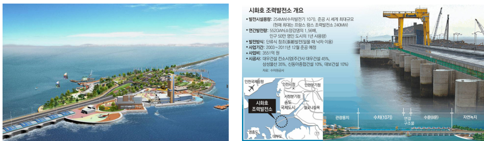
시화호 조력발전소 전경
